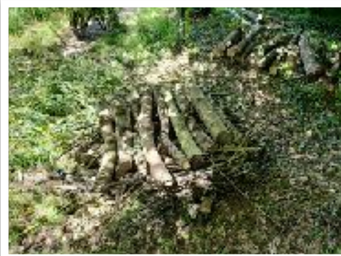
Construction du refuge
